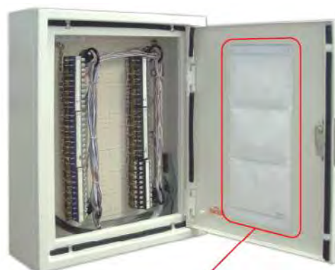
端子盤への「G-プレス」施工例
