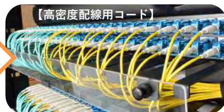
外径Φ2mmコードに光ファイバ素線が2本入っています
