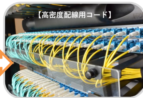
外径Φ2mmコードに光ファイバが2本入っています
